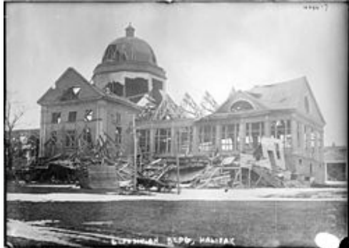
Bâtiment partiellement soufflé par l'explosion par l'explosion
