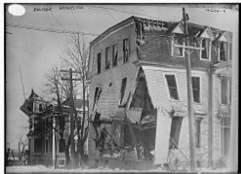
.Maison partiellement détruite
