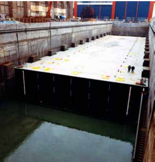
Ouvrage Cachin : la plate-forme en cours de descente.
