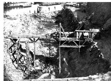
Travaux du bassin du Salou (Musée national de la marine). Après arasement de la butte du Salou, le grand bassin est creusé dans le roc.
