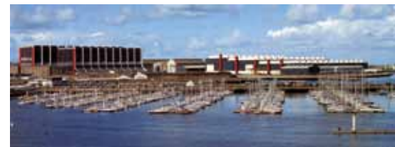
A droite, l'atelier Coques, à gauche le chantier Laubeuf.
