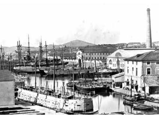
Darse de Castigneanu de l'arsenal de Toulon. La nouvelle darse, mise en service vers 1856, est bordée par les ateliers de fonderie, de machines et d'ajustage.
