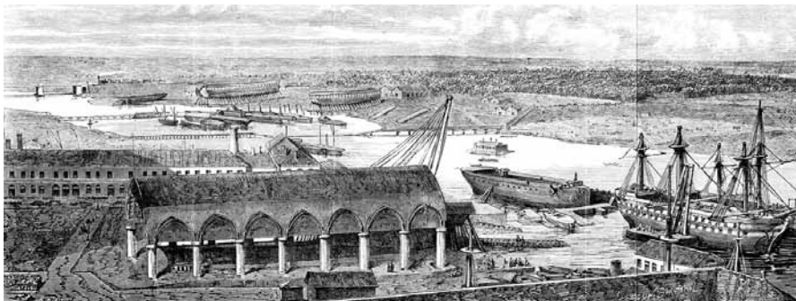
L'arsenal de Lorient vers 1860. La cale couverte se dresse au premier-plan, devant l'atelier à métaux. En rive gauche, le chantier de Caudan se dote de ses premières cales de construction avant son extension.
