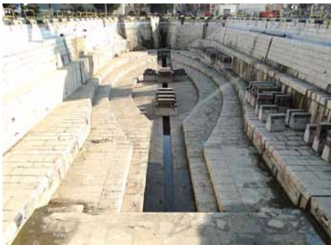
Le bassin Grognard (Photo Luc Malchair) Plus de deux siècles après sa mise en service, la forme Grognard est toujours exploitée par la marine nationale. La qualité de sa construction initiale n'a pas nécessité de travaux de conservation ou de remise en état significatifs.
