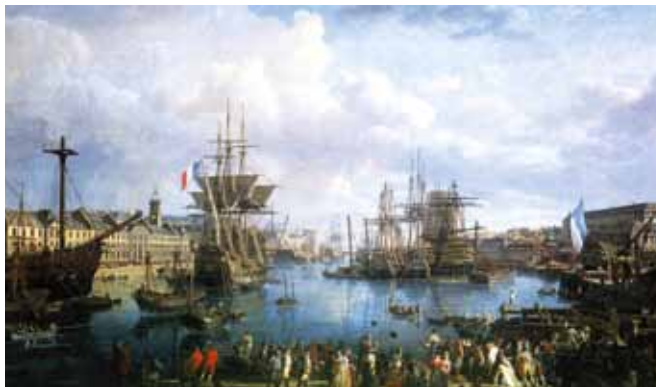
Vue du port de Brest, JF Hue, 1794 (Musée national de la marine). La vue est prise depuis les abords des bassins de Pontaniou, en direction de l'aval. Sur la gauche se déroule la façade majestueuse du magasin général, avec le château en arrière-plan. En rive droite, la caserne des matelots domine les bassins. A ses pieds se trouvent les magasins hérités de l'arsenal du début du XVIII e siècle.
