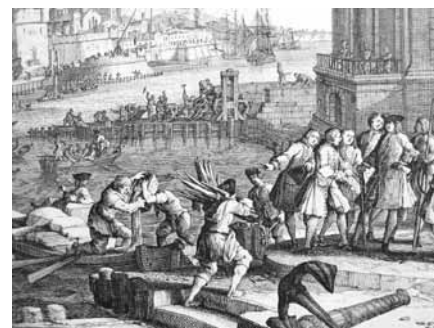
Représentation symbolique des travaux maritimes, Béliidor, 1750 (Coll. Part. BC). Utilisée en frontispice de l'Architecture hydraulique, cette vignette représente bien l'activité des ingénieurs de la marine. Visitant un chantier d'ouvrage à la mer, l'intendant de la marine, entouré de son état-major, écoute le compte-rendu d'un ingénieur, plan en main et entouré de ses maîtres d'ouvrages et piqueurs.
