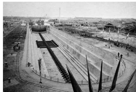
Bassin de radoub de l'arsenal de Saigon (Service historique de la défense). Du fait de la mauvaise qualité du terrain de fondation, l'arsenal est d'abord doté d'un dock flottant, assemblé en 1865. Le bassin sera finalement construit vingt ans plus tard.
