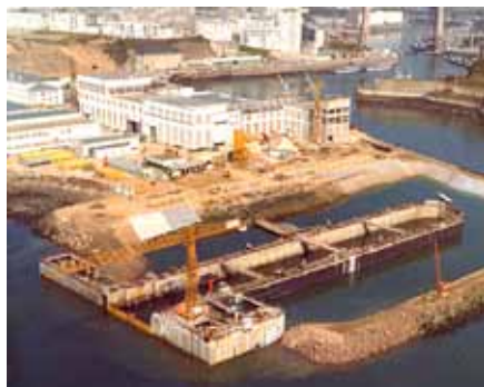
Construction du bassin 10 dans l'arsenal de Brest, 1972.
