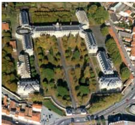
Ancien hôpital de la marine à Rochefort. (Archives municipales de Rochefort). Toufaire a doté Rochefort d'un monument remarquable, qui est resté en service jusqu'à la fin des années 1980. Propriété privée, son devenir est une interrogation.
