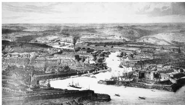
Vue générale de Brest, vers 1860 (Coll. Part.). La nouvelle cheminée des ateliers du plateau des Capucins crache sa fumée, tandis que, à l'arrière-plan, la montagne du Salou est en cours d'arasement. Les rives de la Penfeld sont chargées des constructions de Choquet de Lindu, et dominées par celle du XIX e siècle.
