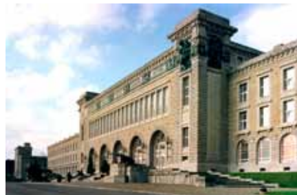
Façade de l'ancienne École navale (cliché Ronot) Reconstruite à l'identique après les destructions de la seconde guerre mondiale, la façade de l'ancienne école navale de Georges Leygues exprime sobriété et la solennité face à la rade.
