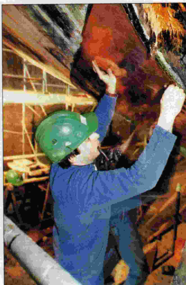
Les œuvres vives sont entièrement doublées de plaques de cuivre. Ici, mise en place de plaques de cuivre neuves. (Photo APP Brest / QM2 Kerivel)
