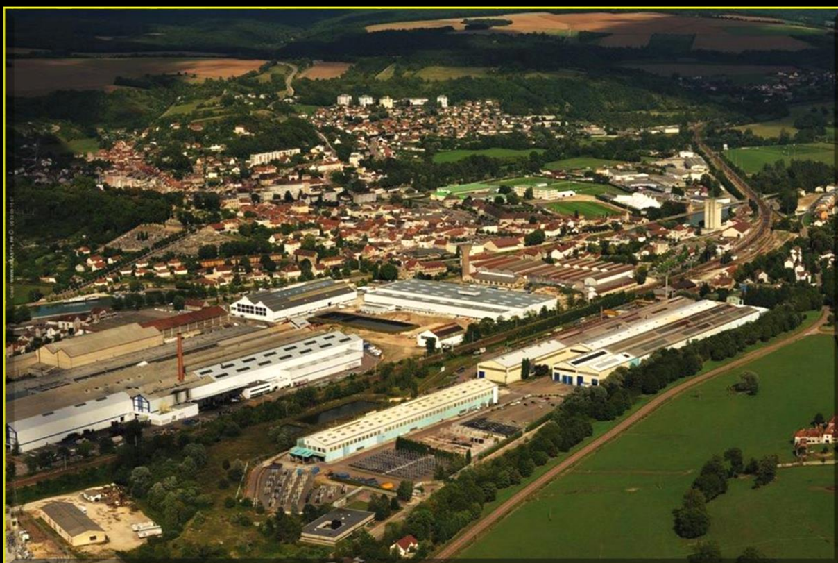
METAL VALLEY - SITE DE MONTBARD - VALLÉE DE L'ARMANÇON PHOTO UN - 2010 - BOURGOGNE - USINES VALLOUREC.
