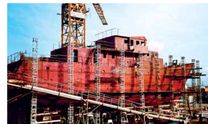
Le Chacal en construction à Villeneuve-la-Garenne. (Marine nationale)
