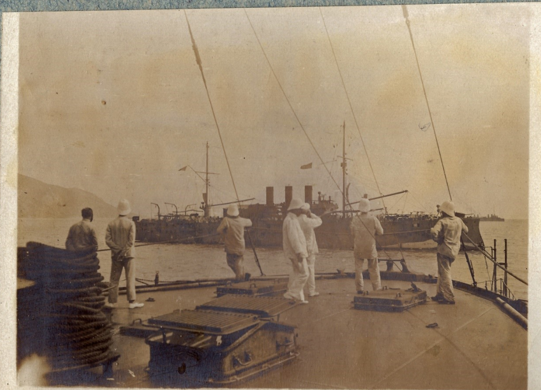
12 septembre La Foudre fait route pour Port Saïd avec 1000 réfugiés
