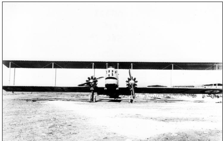
Vue de face du F.65 n° 216 (5B2.7) à Fès en 1926. L'appareil est armé et on distingue les deux bombes de 120 kg sous l'avant du fuselage. (source Grimaud)
