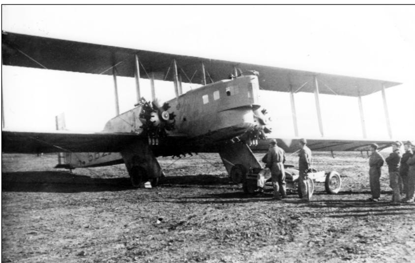
Fès, fin 1925, point fixe du F. 65 n° 216 (5B2.7). Cet appareil s'apprête à décoller pour un vol d'essai ou une mission photo car ses lance-bombes sont vides. (source Poggi)
