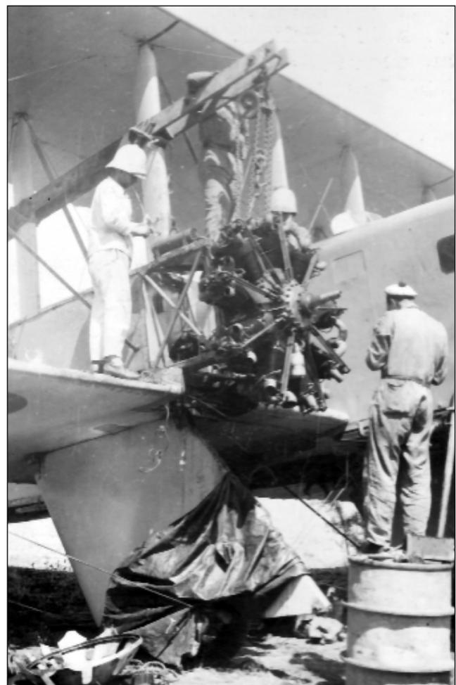
Rafo, le 29 juin 1926. Des mécaniciens procèdent au montage sur le 5B2.9 du moteur de rechange « aéroporté » par le 5B2.4. A noter la « chèvre » installée sur les mâts de la voilure.
