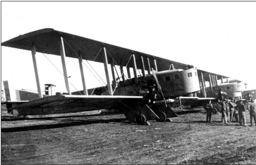
Prêts pour mission ; fin 1925, trois Farman Goliath (un 60 et deux 65) alignés sur le terrain de Fès avant le décollage. Les bombes sont à poste et les équipages attendent le signal de mise en route des moteurs. A noter que les affûts doubles de Lewis sont montés. (source Poggi)
